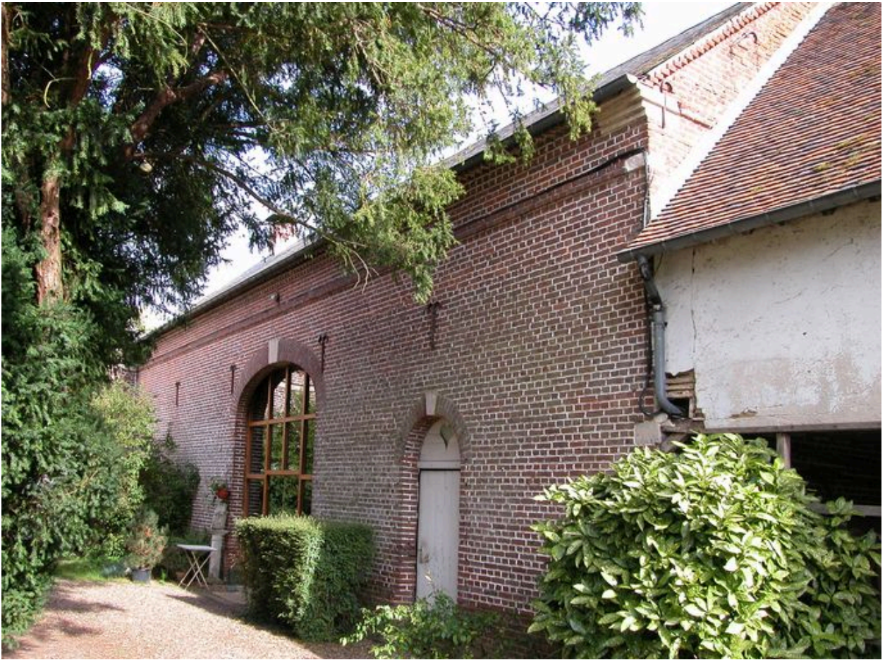
Les granges, façade sur cour.
