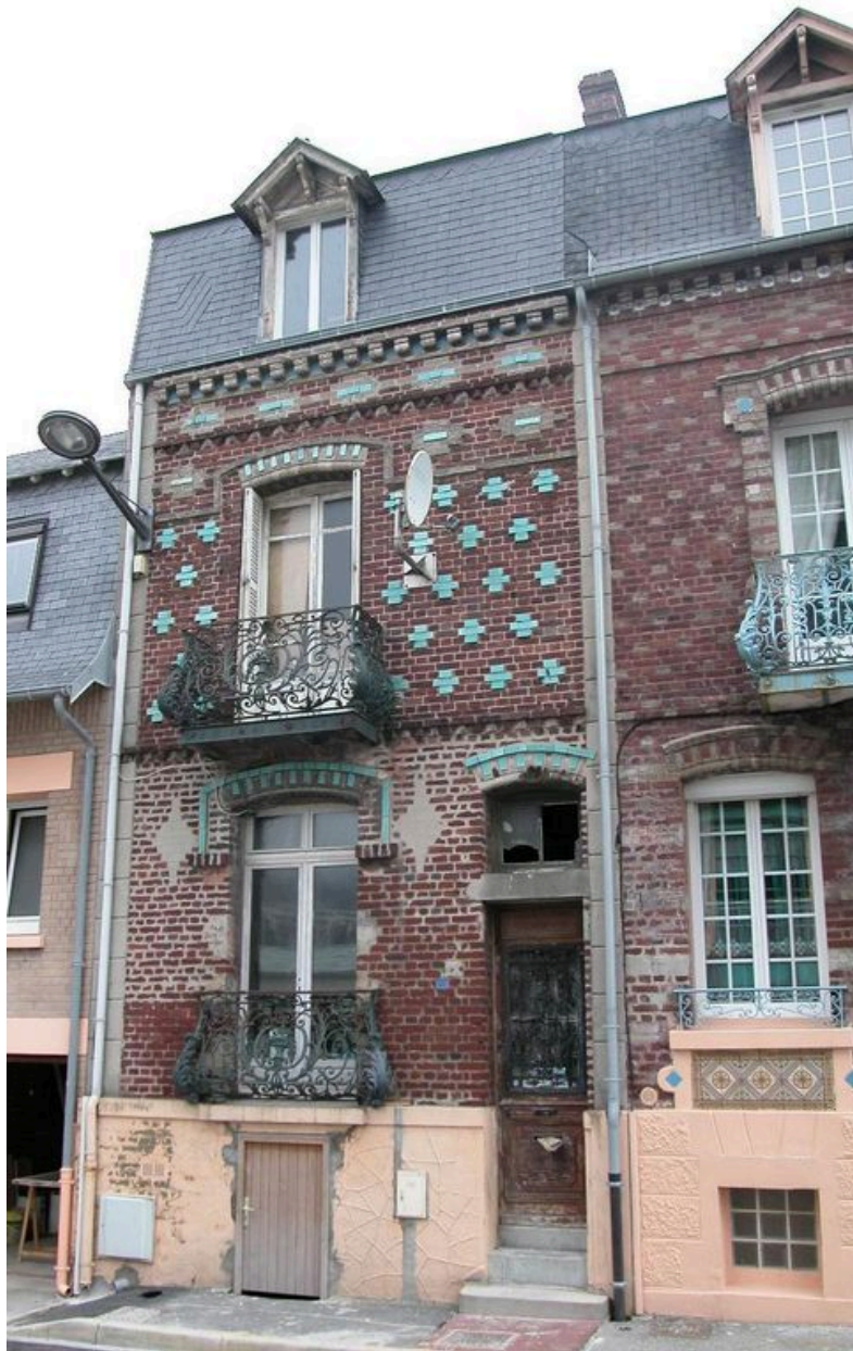
Vue d'ensemble de la maison rue Boucher-de-Perthes.
