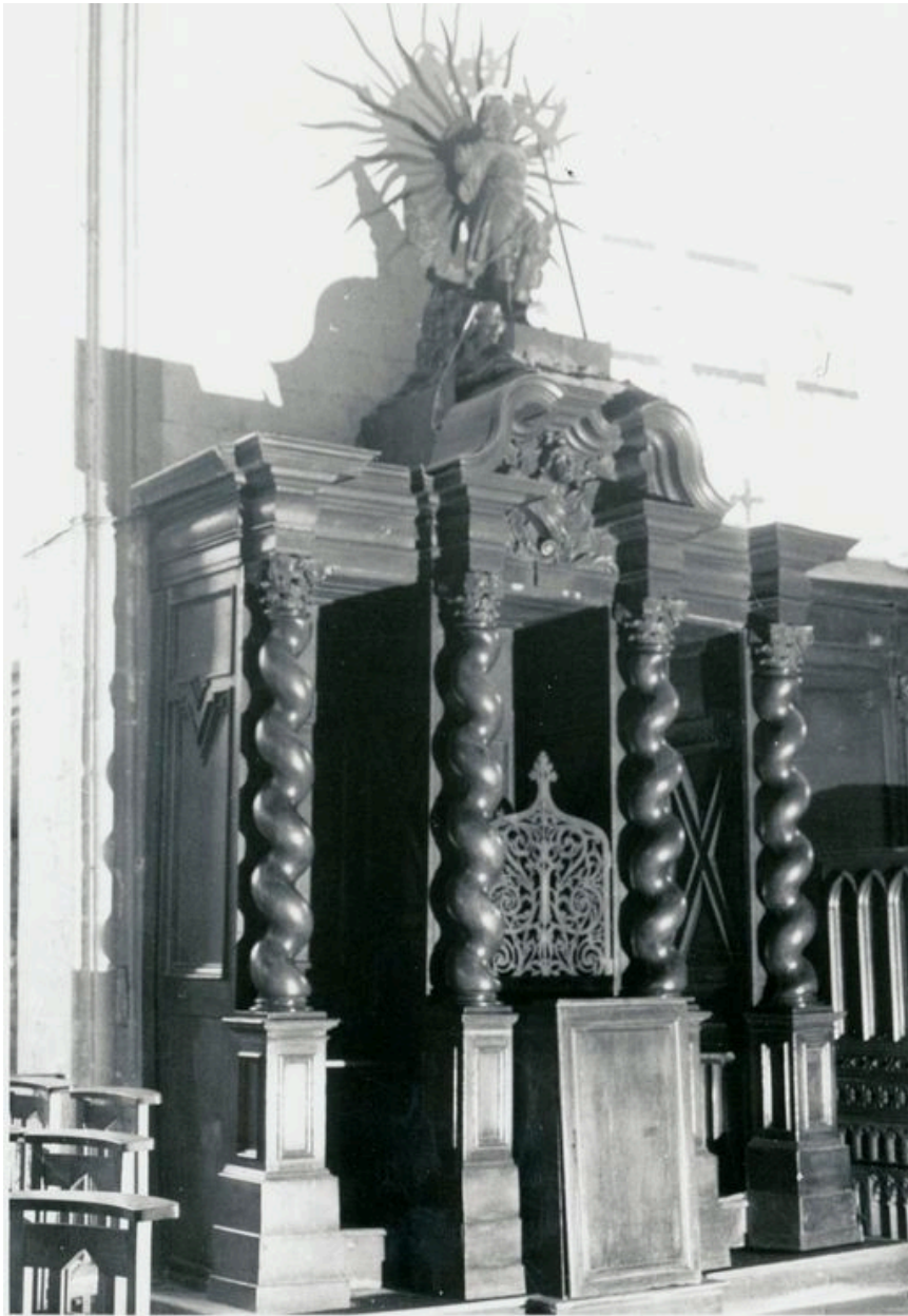
Vue générale, bas côté-sud (phot. Wintrebert, 1978, fonds AOA62)
