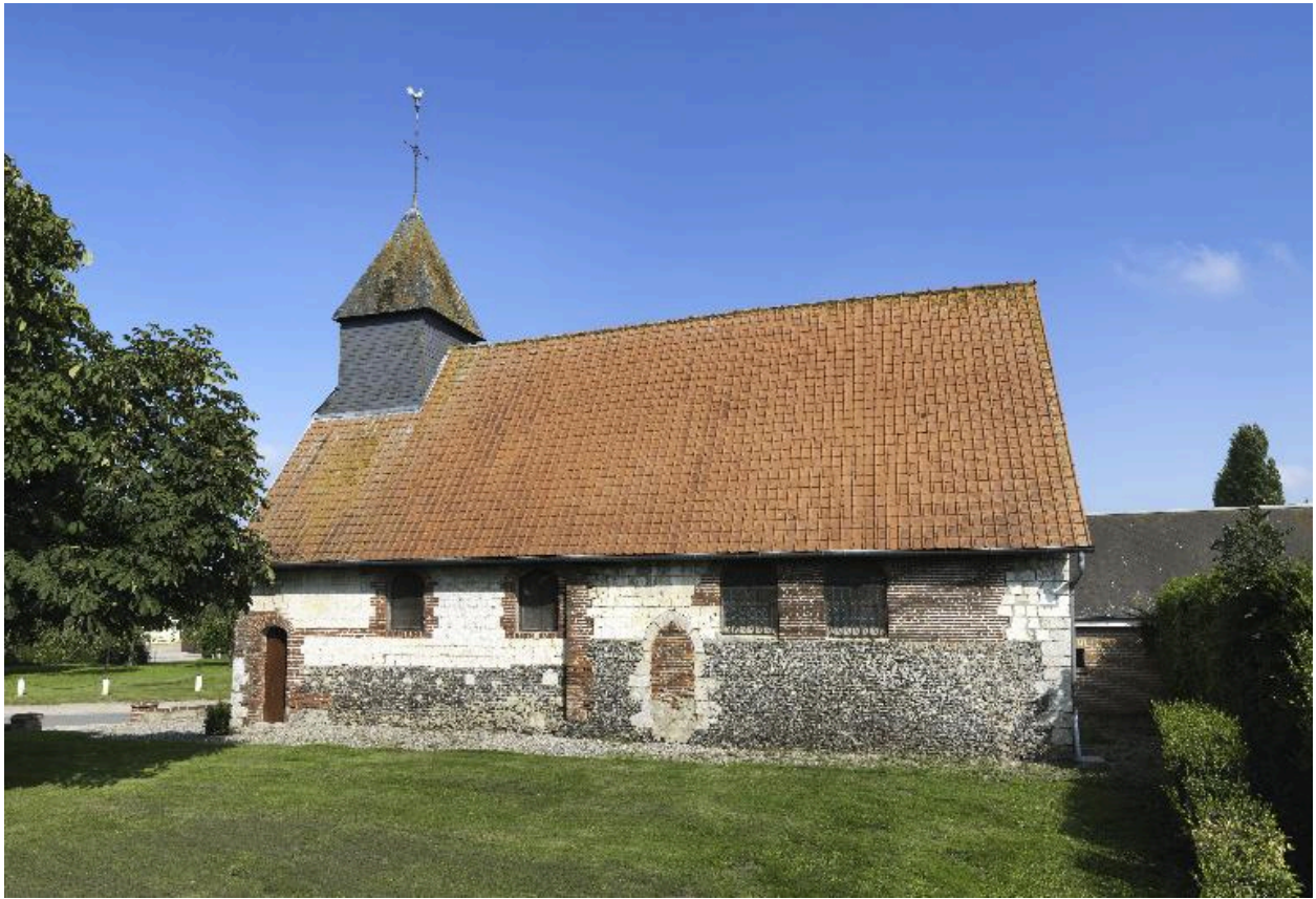
Vue du mur gouttereau sud.
