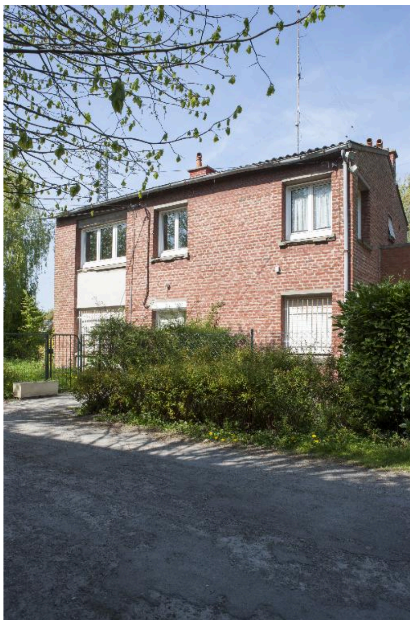
Façade de la maison paroissiale.
