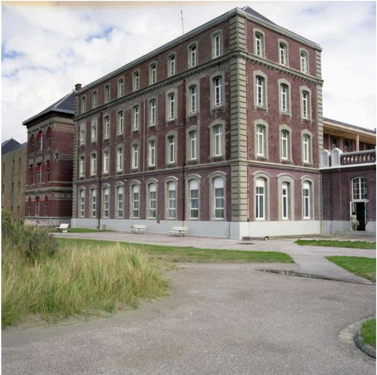
Elévation antérieure donnant sur la plage, détail du pavillon nord, vue de trois-quarts droit.
