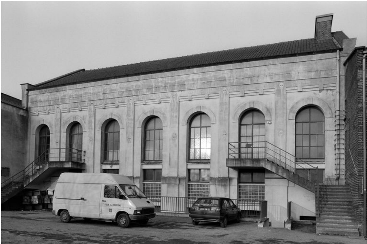
Salle des machines, en 1991 : élévation sud.
