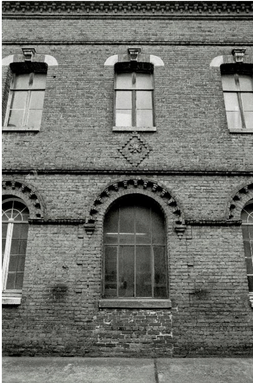
Détail de baies de l'atelier de fabrication, en 1990.
