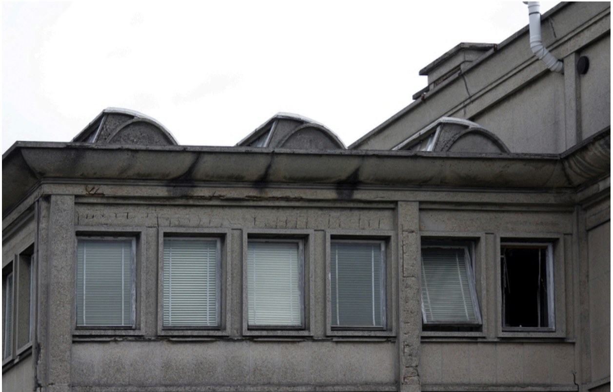
Détail de la façade antérieure des services généraux.
