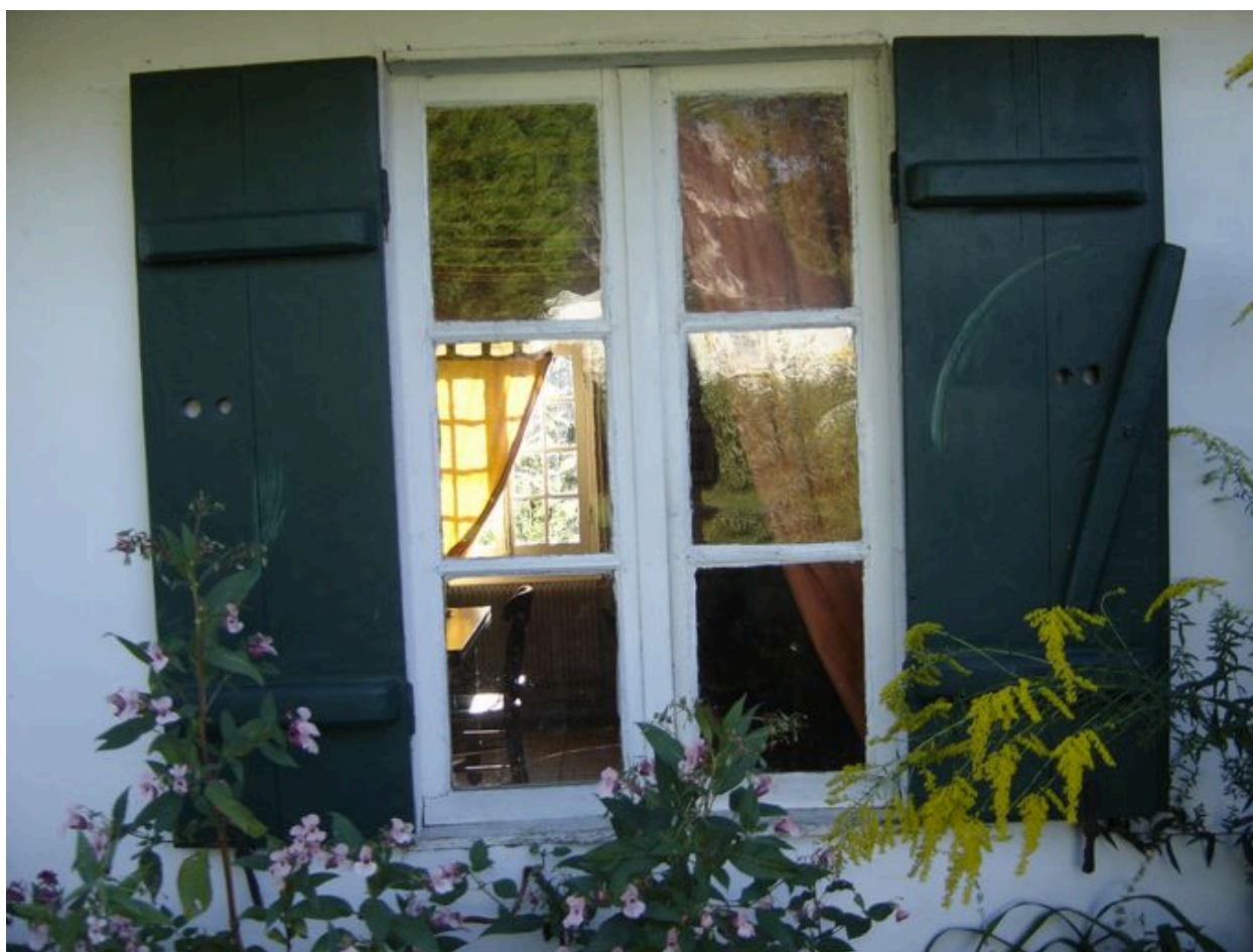
Vue détaillée d'un contrevent et de l'huissierie d'origine de la fenêtre.
