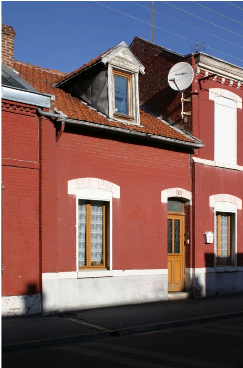
Façade antérieure d'un logement ouvrier peu modifié depuis la construction.
