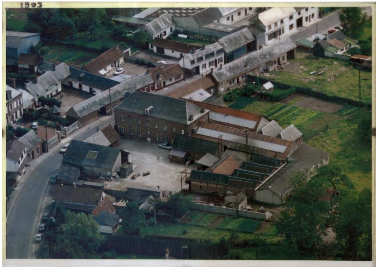
Vue de l'usine, vers 1990.
