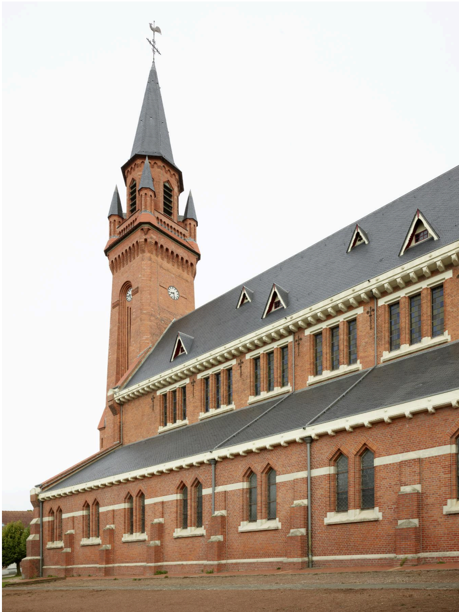
Vue générale de la façade sud.
