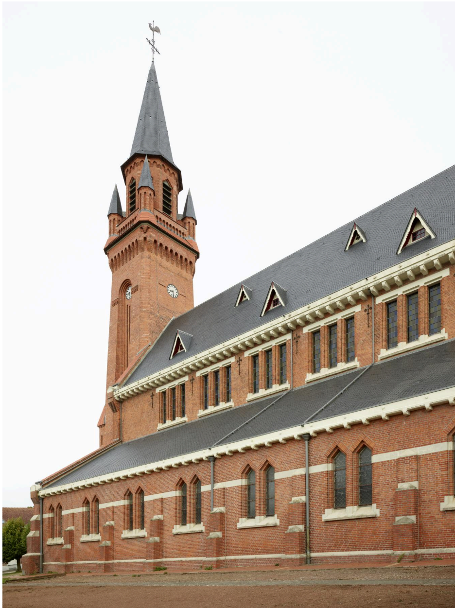
Vue générale de la façade sud.
