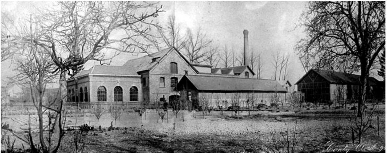
Vue de la salle des machines, photographie, vers 1890 (coll. part.).
