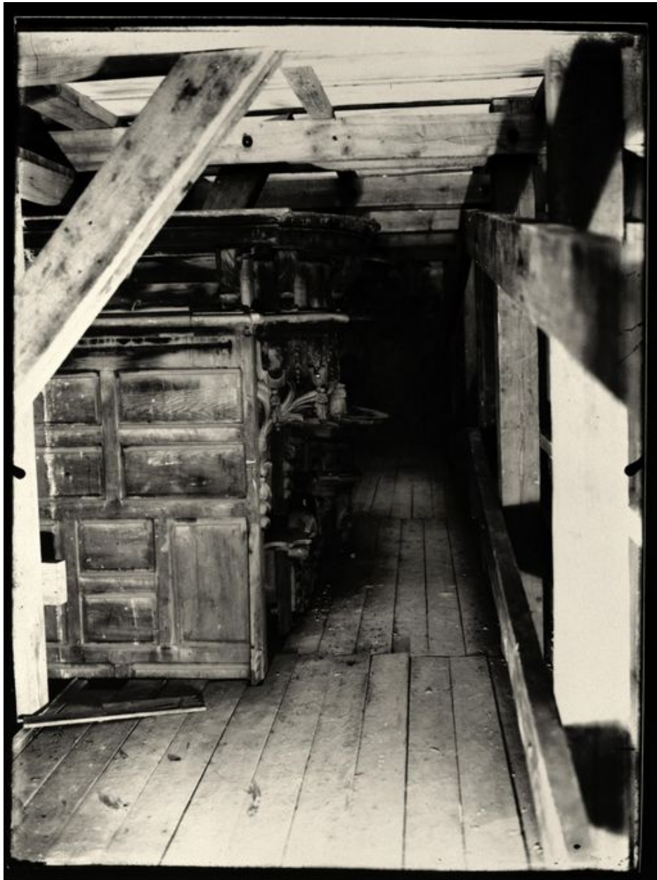
Vue latérale du positif (photographie des années 1920).
