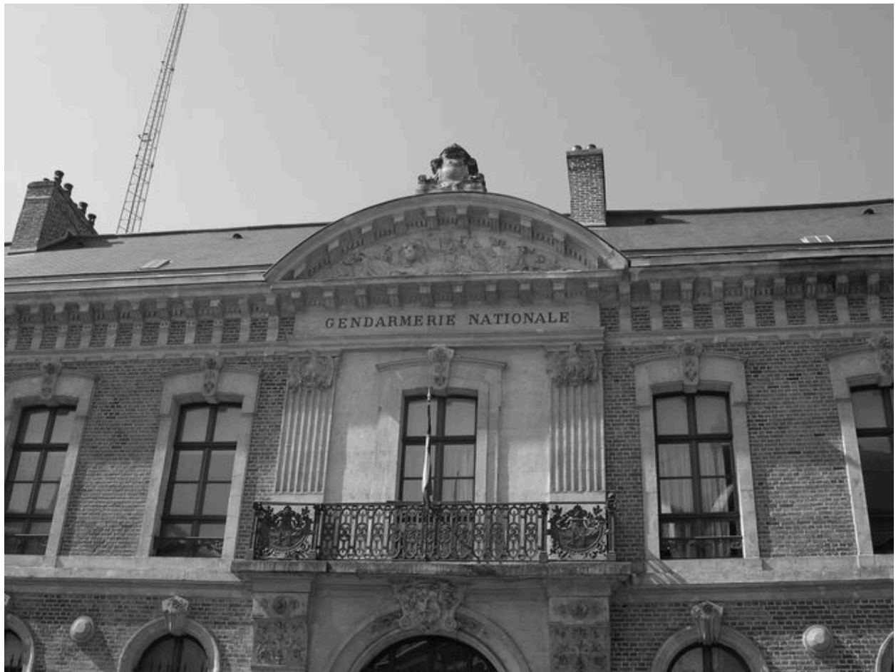
Vue de détail sur le décor du corps central.
