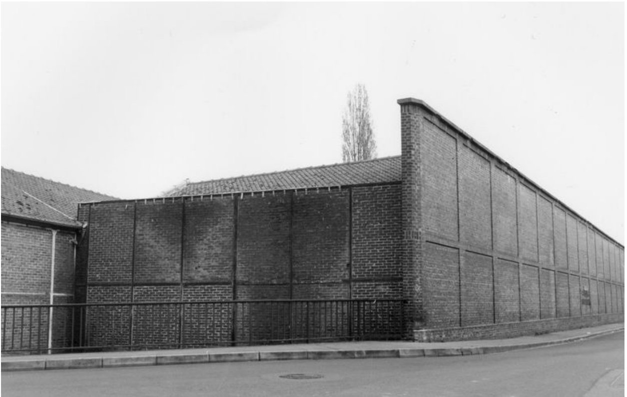
Les ateliers bordant la rue Delahaye, vus du sud.
