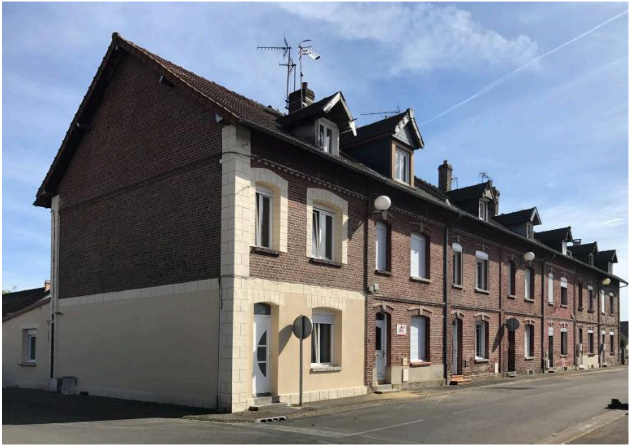
Vue des logements situés à l'est de la place de la Raffinerie (2 à 14 place de la Raffinerie), depuis le nord-ouest
