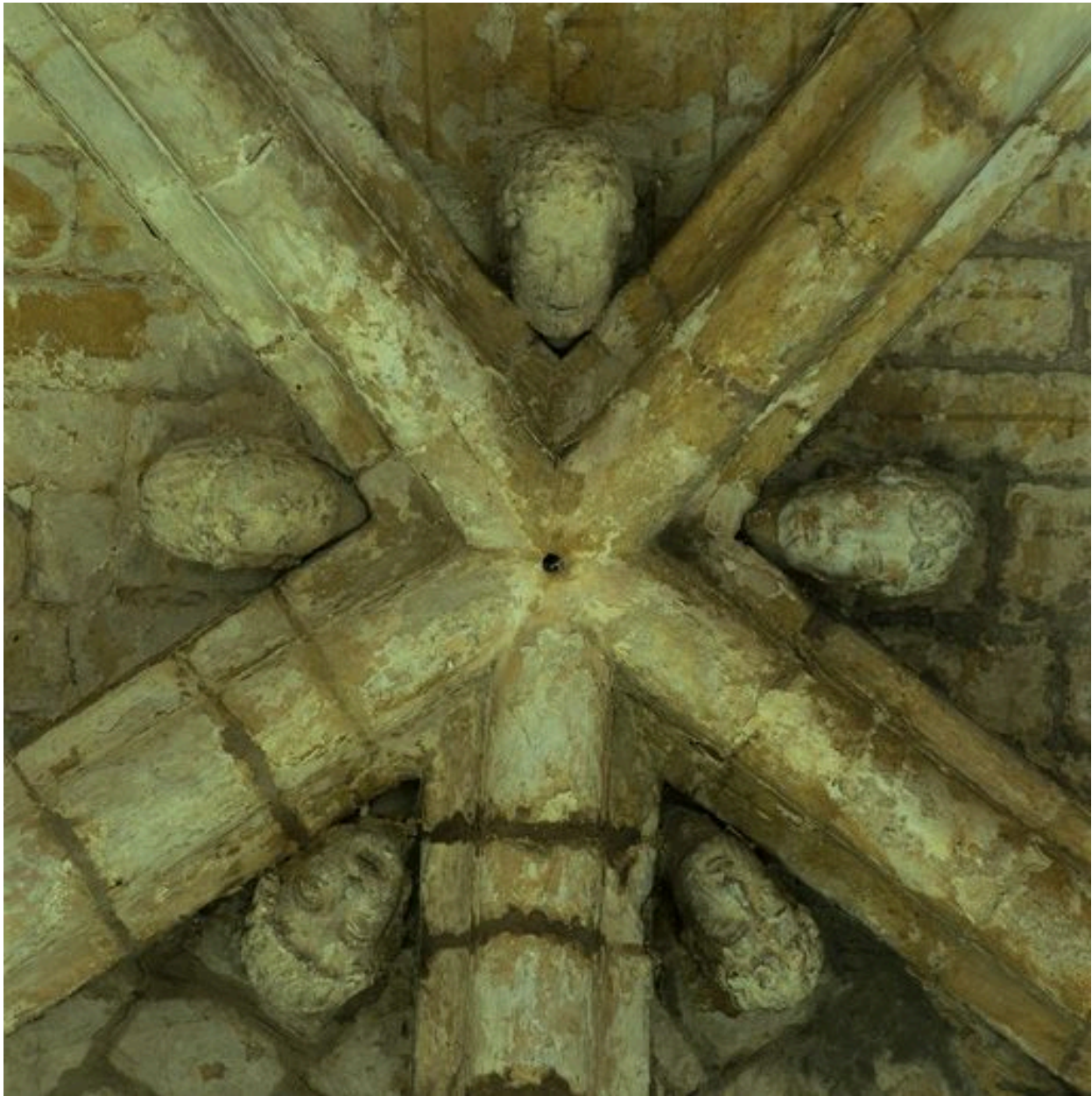
Vue intérieure des tribunes du choeur, détail des voûtes.
