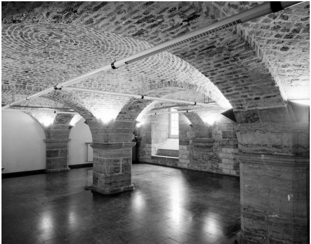
Corps de bâtiment fermant l'avant de la cour d'honneur, sous-sol, salle située sur le côté droit par rapport au passage d'entrée, vue générale,
