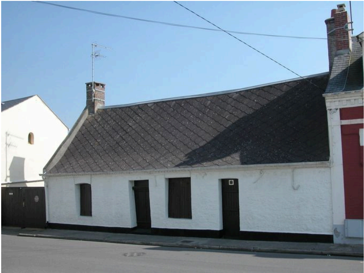
Une maison ancienne (58 rue Léon-Parmentier).
