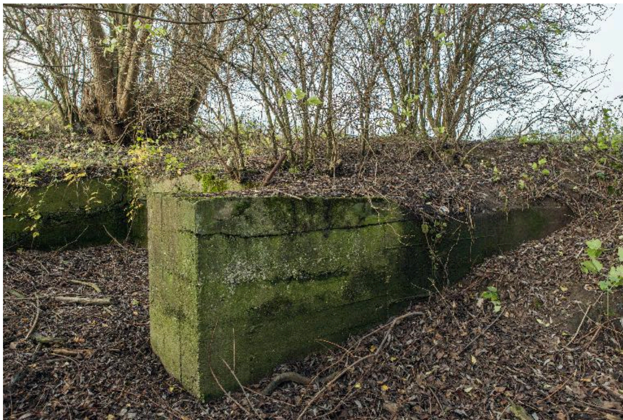
Cuve ouverte entre (88) et (89). Vers l'ouest
