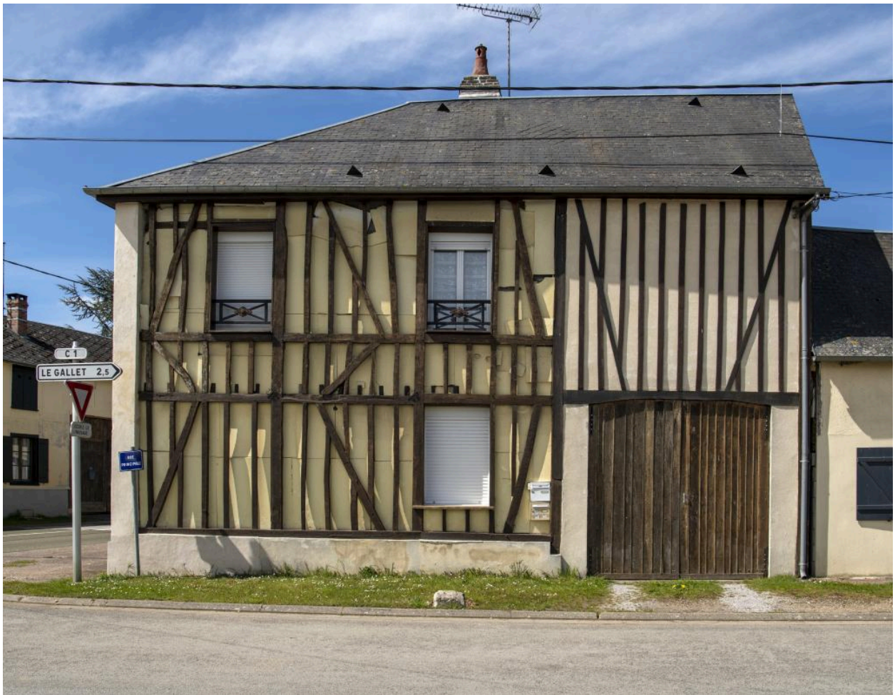
Ancien café, 1867, façade rue Principale, vue depuis l'est.
