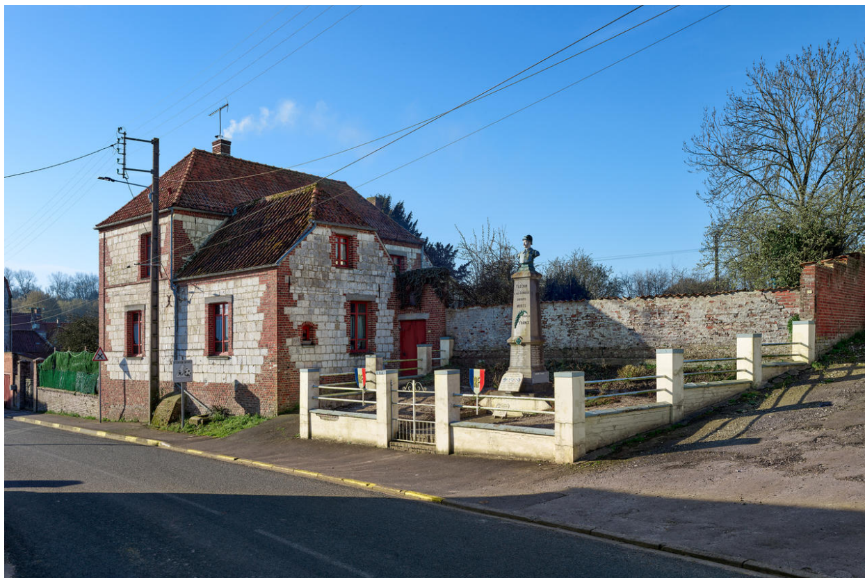
Vue de l'élévation nord.
