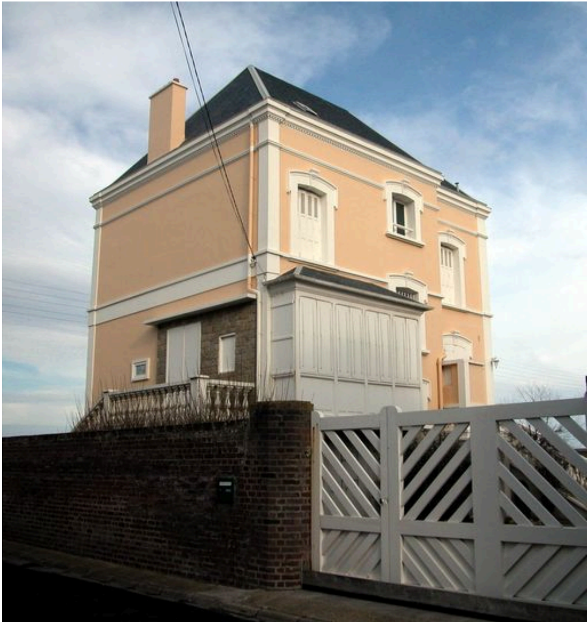
Vue de trois-quarts, élévations postérieure et latérale droite.
