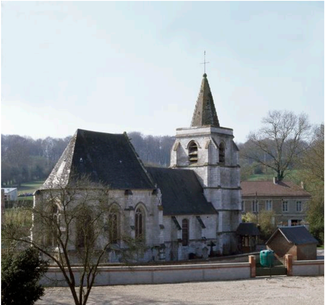
Franqueville, église paroissiale Saint-Pierre, 13e siècle (tour-clocher), 1576 (chœur) et 1881 (flèche, Louis Henry Antoine architecte)
