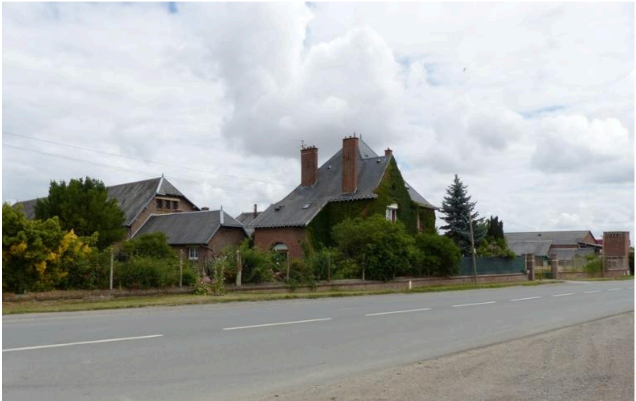
Vue de situation, depuis le sud-ouest.
