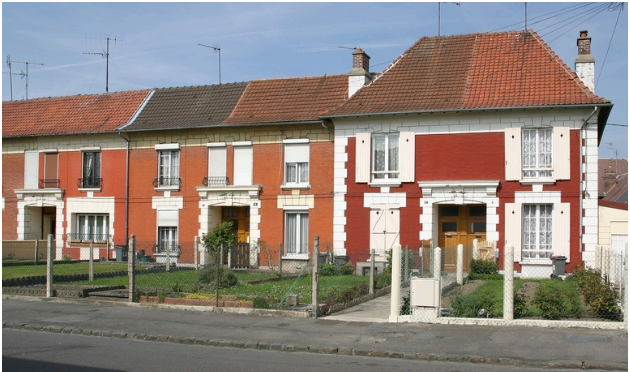
Cité Monplaisir, rue Gonnier.
