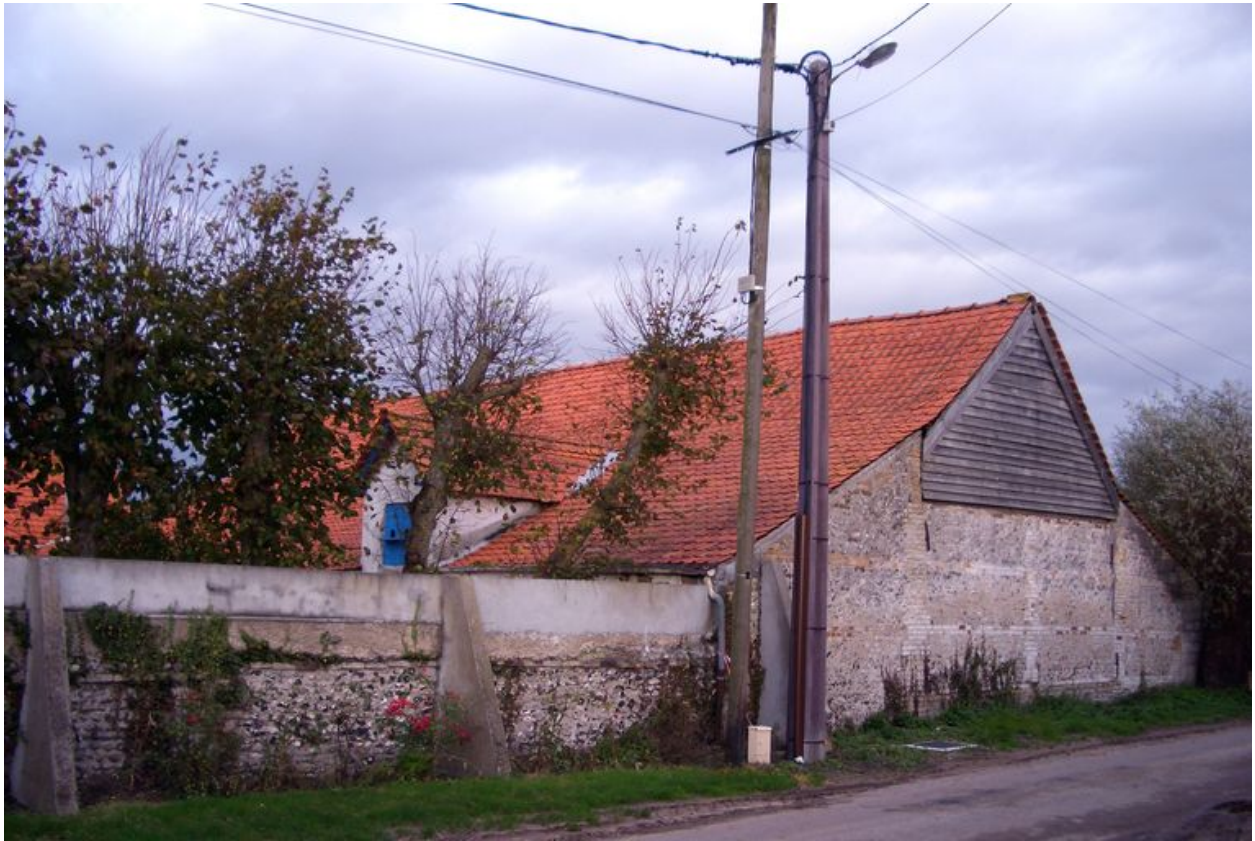
Vue du pignon de la grange.
