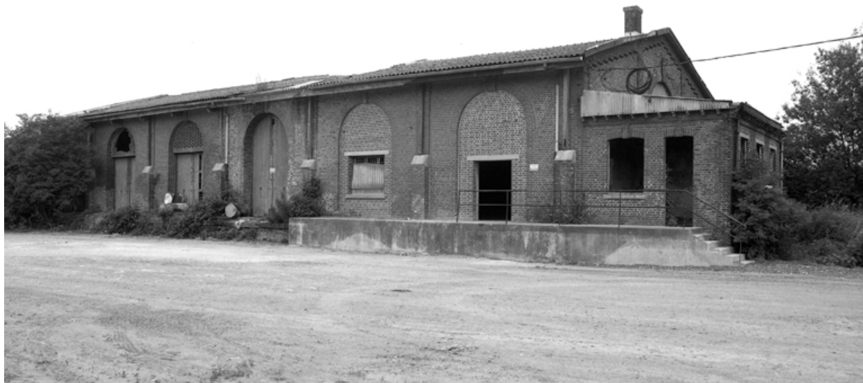
Vue d'ensemble du poste de chargement, depuis le nord-ouest.
