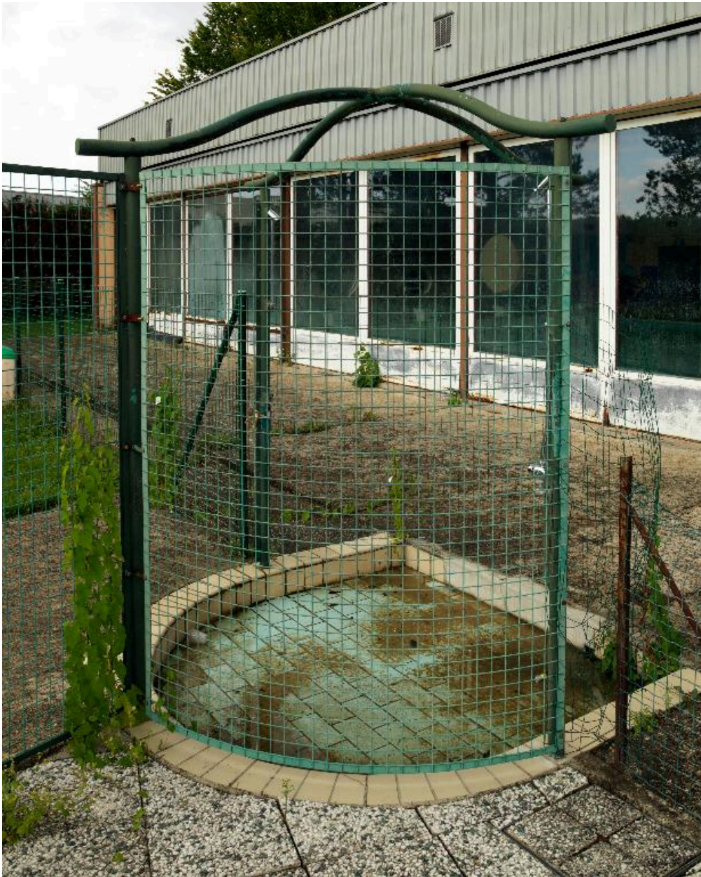
Douche-pédiluve, qui permettait de joindre la piscine Plein Soleil au bassin extérieur.
