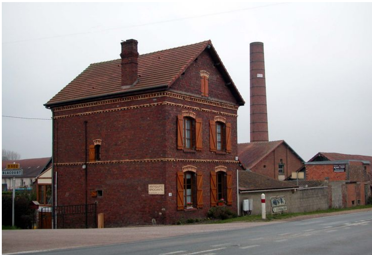
Logement d'ouvrier à l'angle du site industriel.
