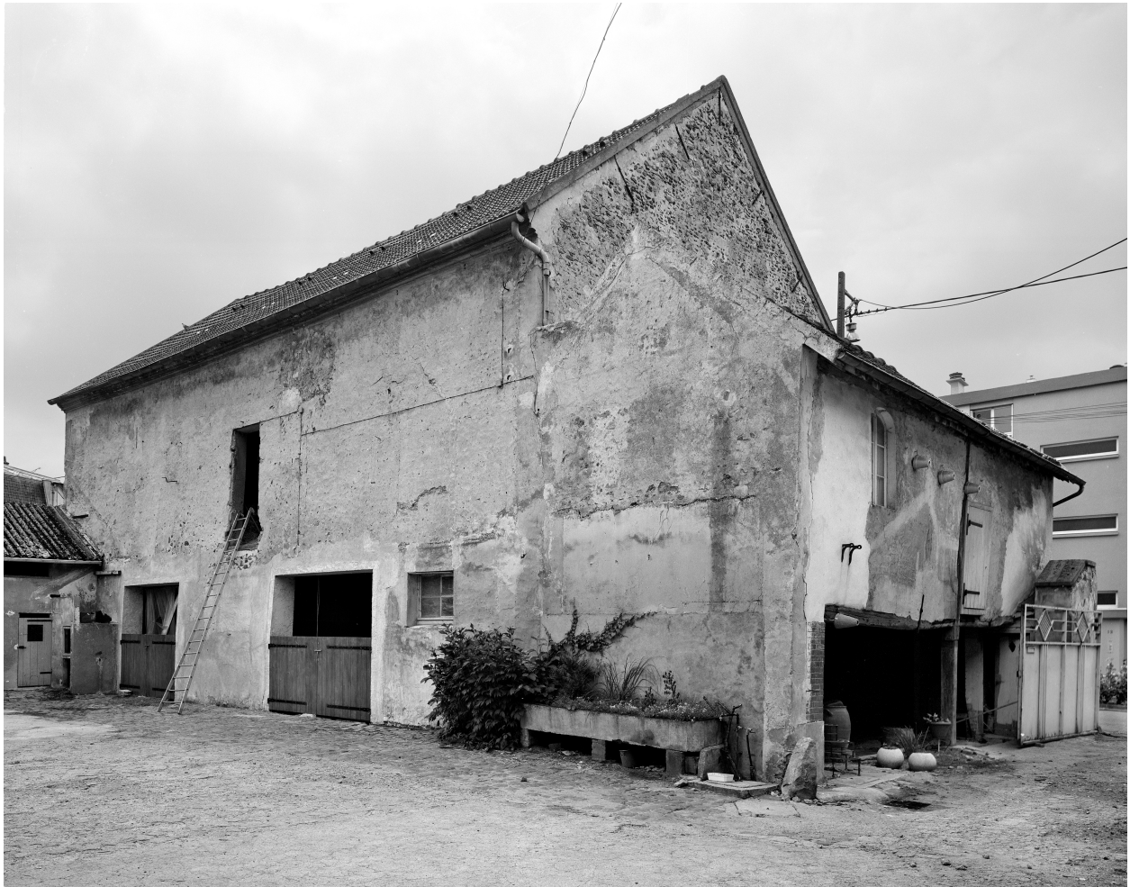
Vue de la grange, ancienne étable.
