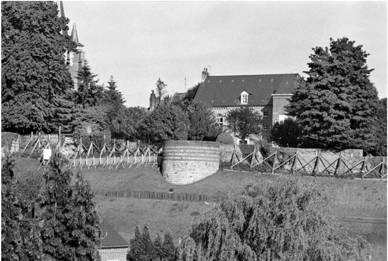
Vue de l'élévation septentrionale, prise au niveau de la sous-préfecture.
