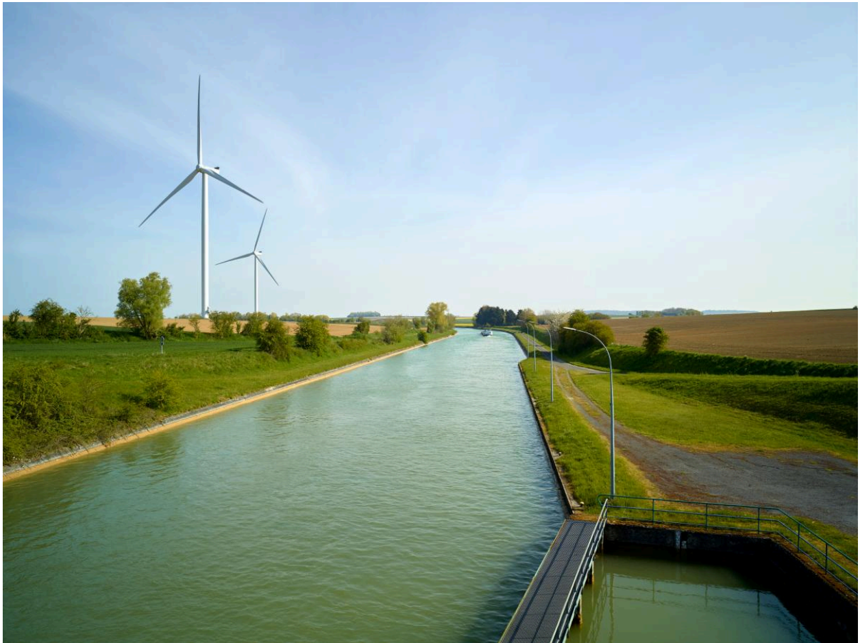
Vue générale sur le canal du Nord en aval du site. Bassin de tranquillisation à droite.
