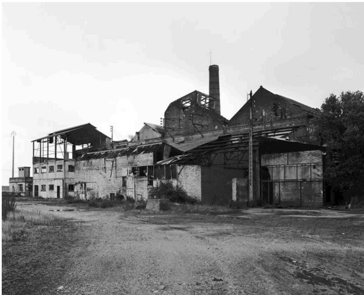
Atelier de fabrication avec laverie au premier plan : vue sud-est.
