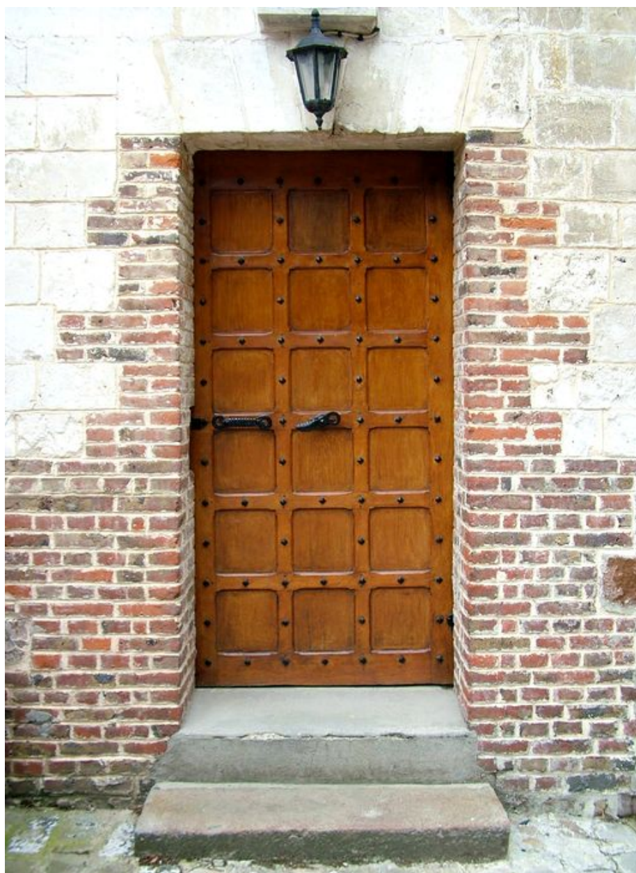
Porte latérale nord.
