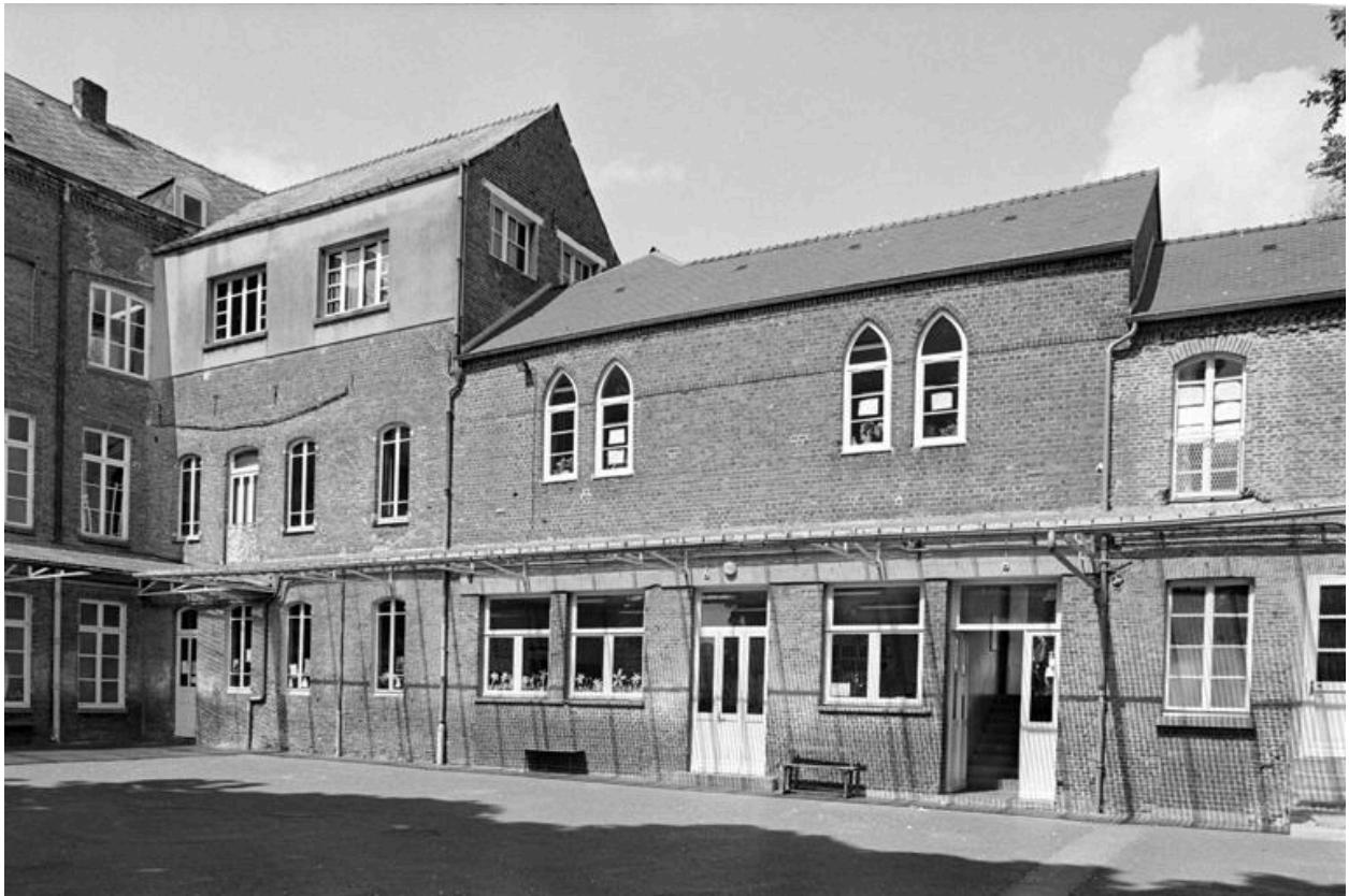
Vue de l'ancien préau surmonté de la chapelle (élevé dans la 2e moitié du 19e siècle).
