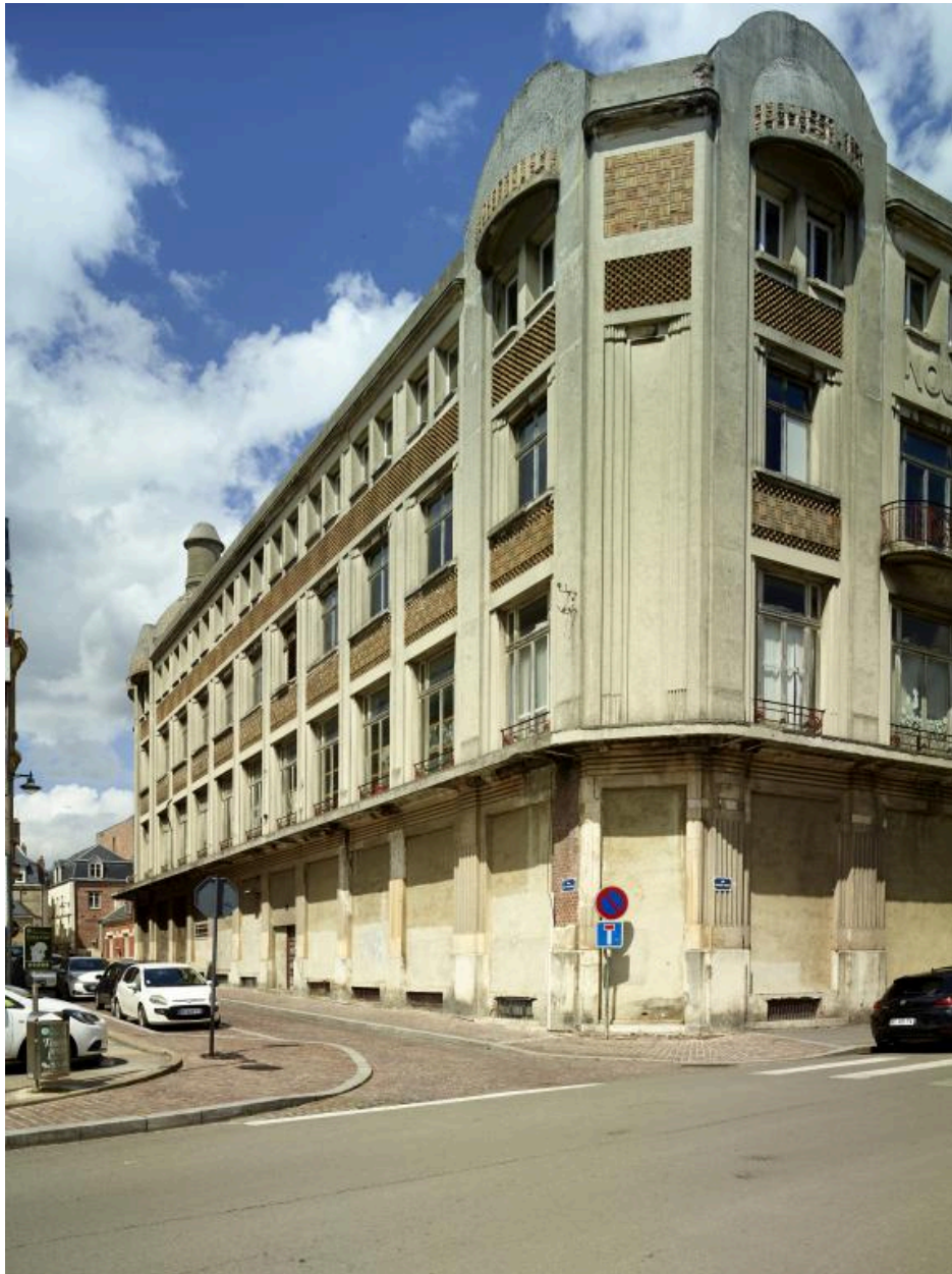
Façade ouest donnant sur la rue Saint-Jacques.
