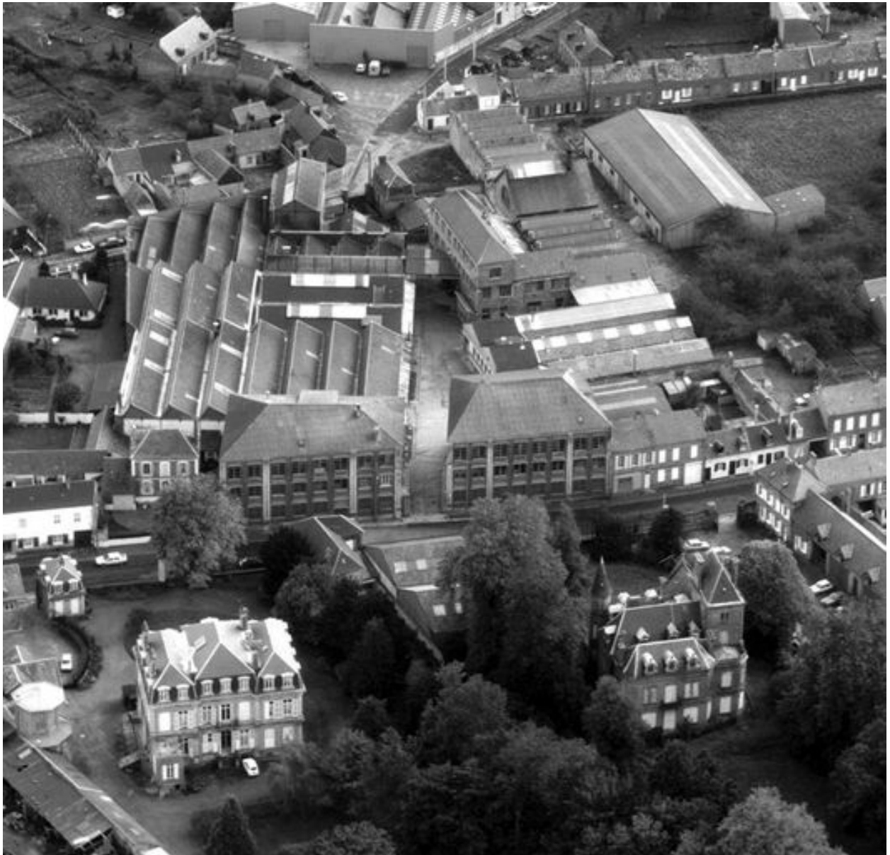
Vue aérienne du site depuis l'ouest, en 1988.
