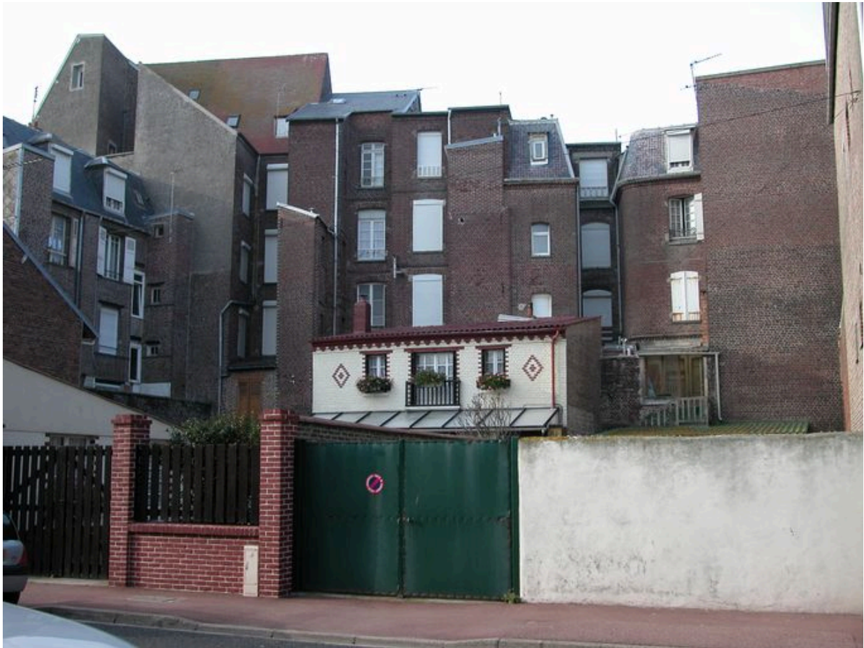
Vue des façades postérieures des maisons du front de mer, et vue de la façade principale de la maison 39 avenue du Maréchal-Foch.
