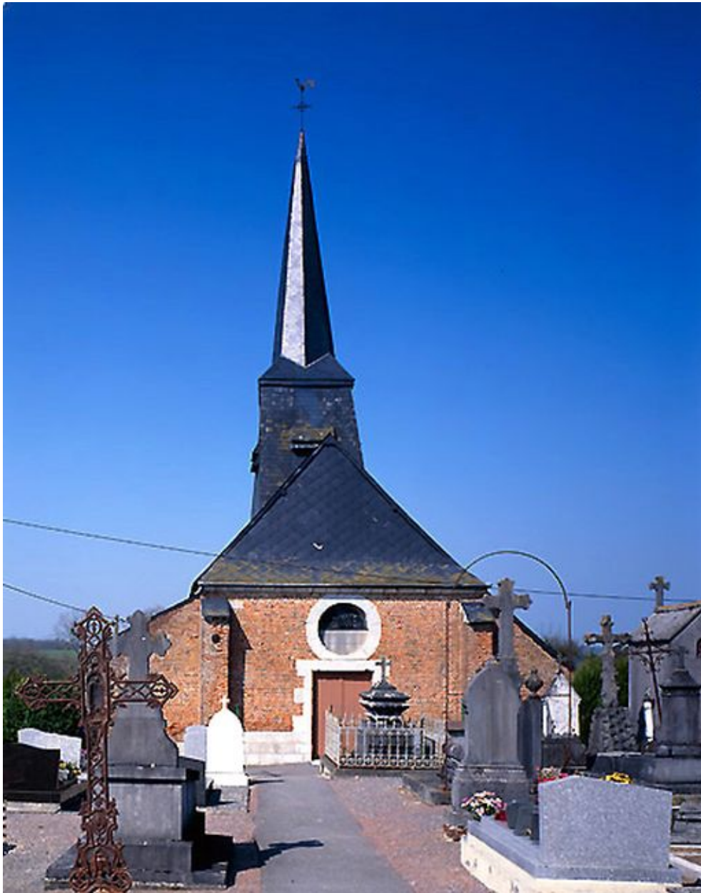
Vue de la façade occidentale.
