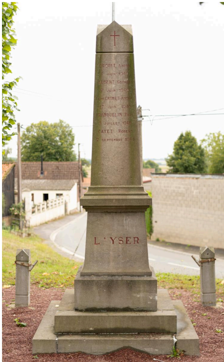
Vue générale depuis l'est
