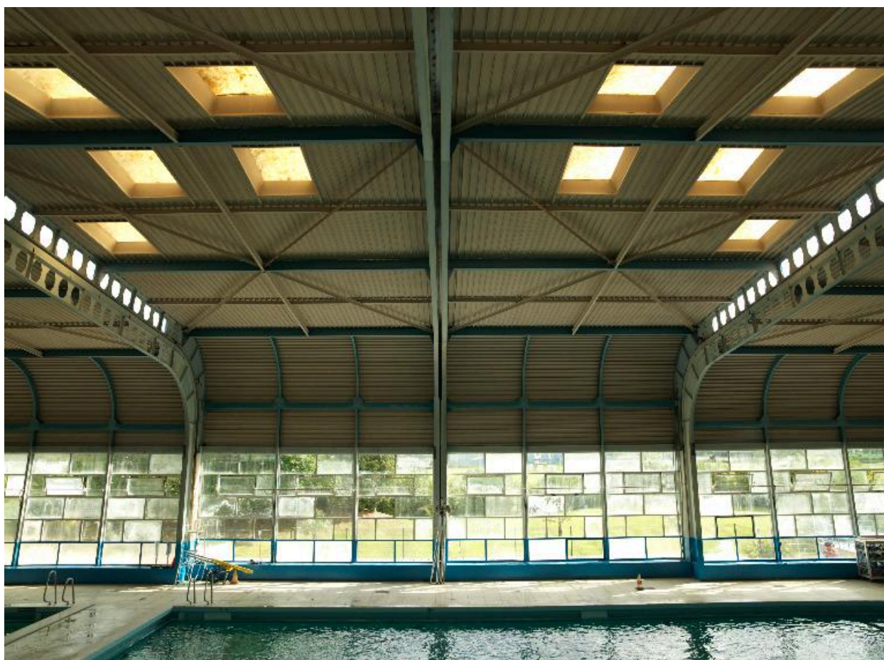
Vue de la structure métallique mobile, percée au centre de 12 skydômes.
