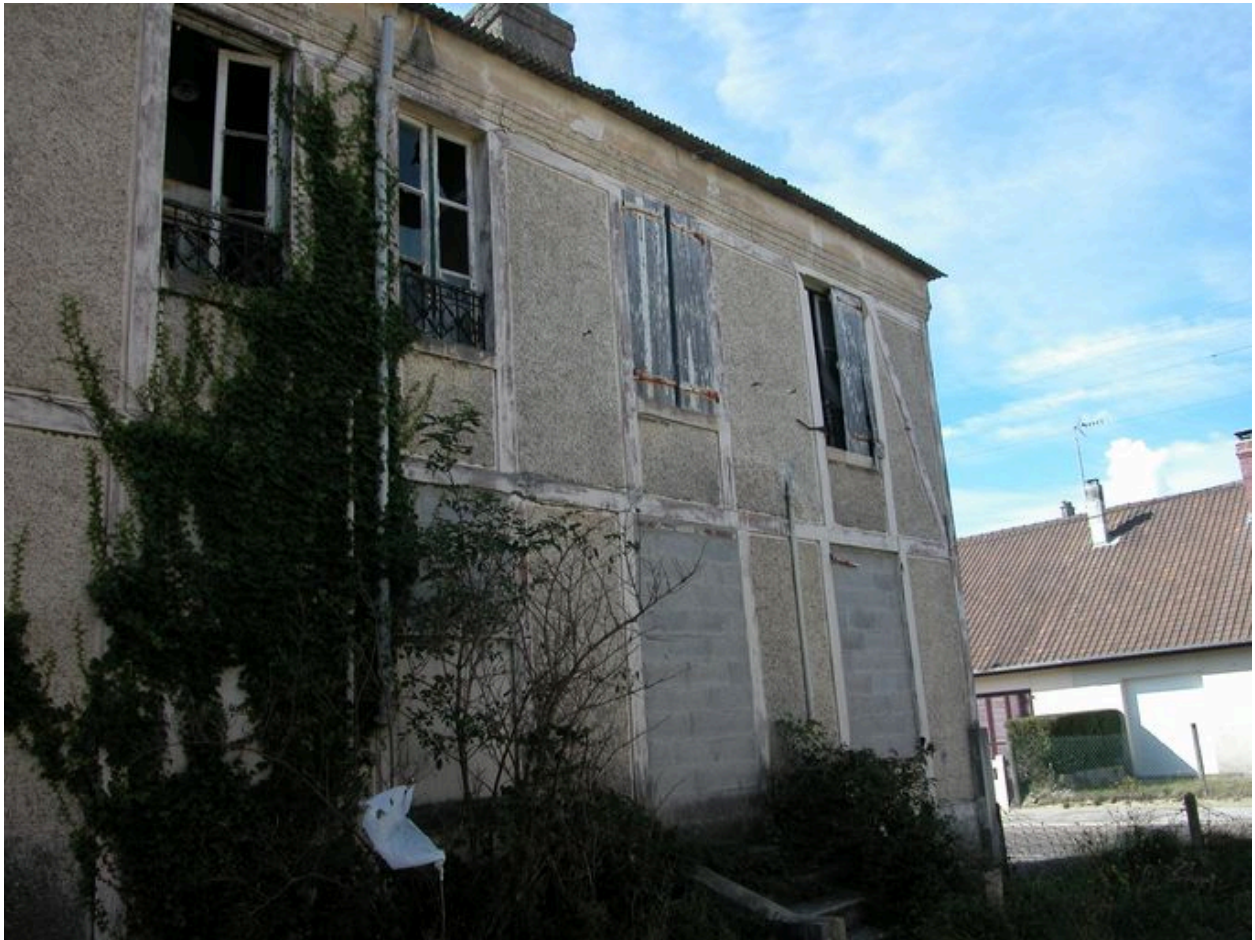
Détail d'un des deux logements, état actuel.
