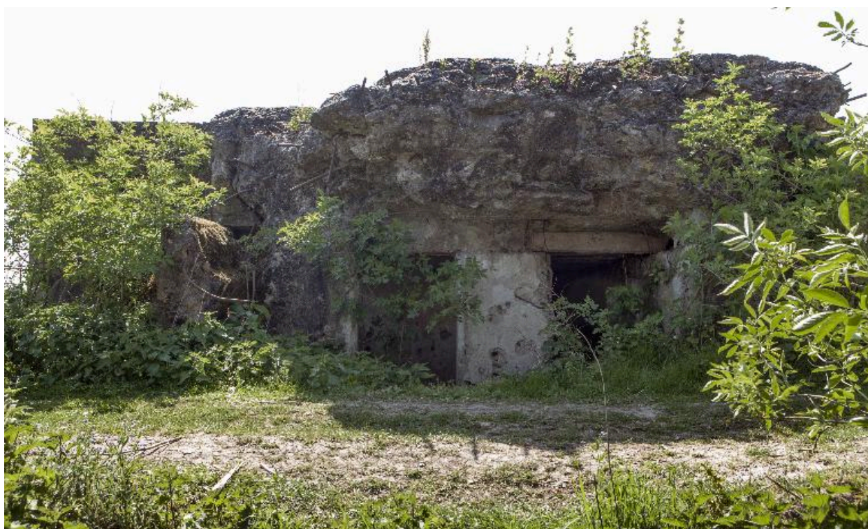
Partie ouest, vers le sud-ouest
