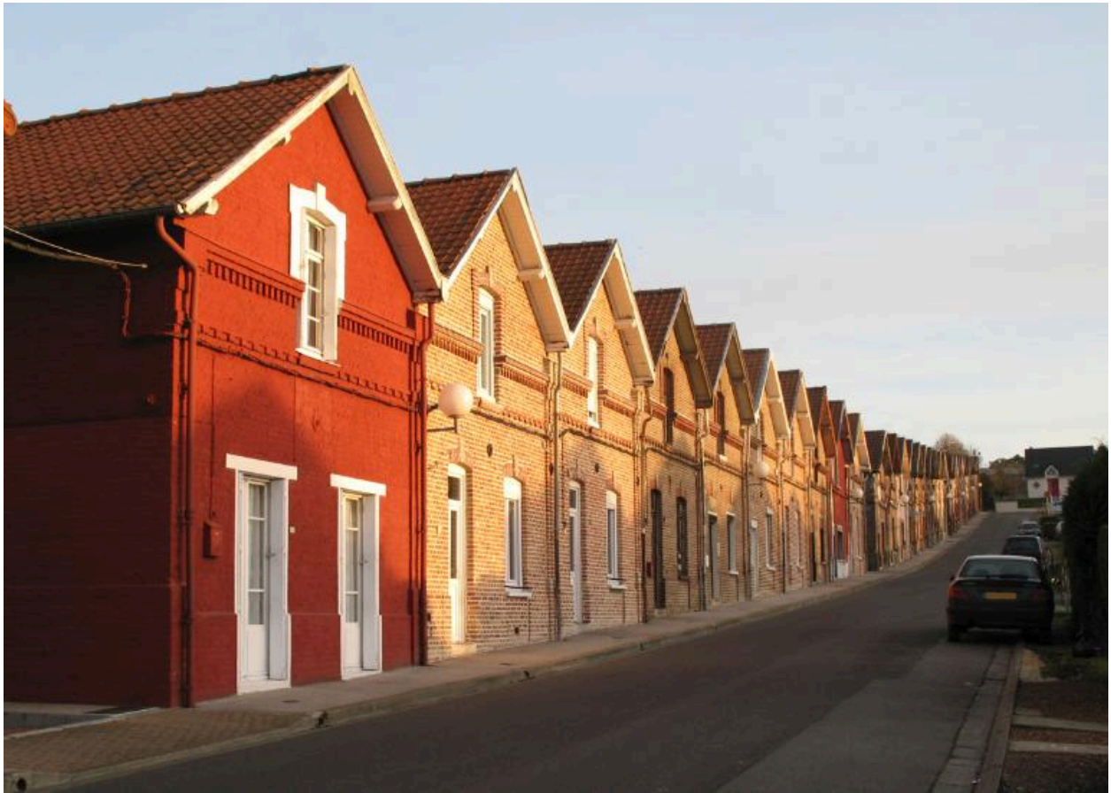
Vue d'ensemble depuis la rue Georges Outrebon.
