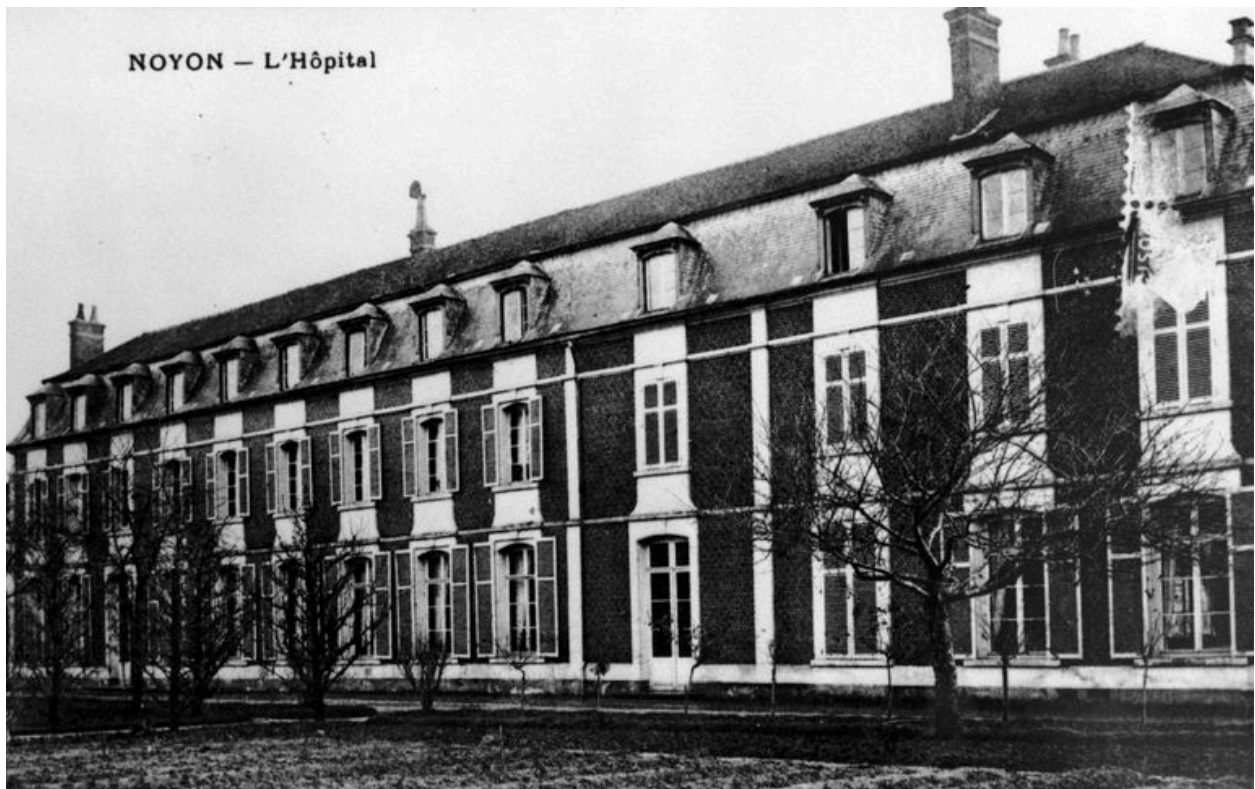
Bâtiment du 19e siècle, avant 1914 (AP).
