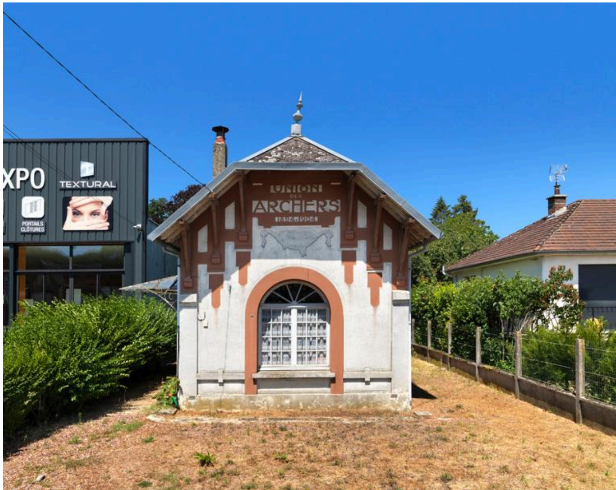
Vue de la façade sud du logis.
