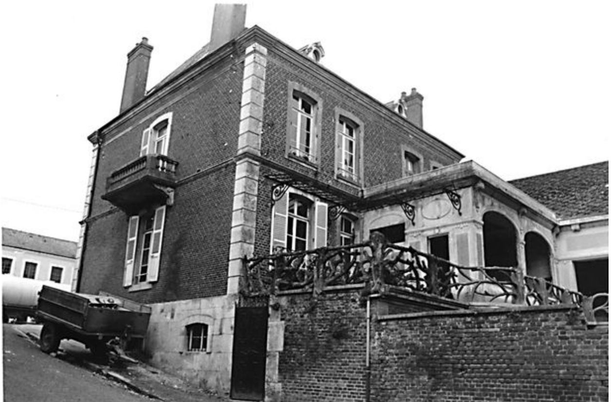
Elévation postérieure depuis le sud-ouest.
